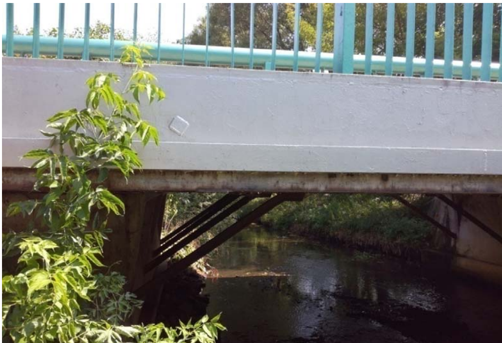
Fot. 3. Widok konstrukcji mostu od strony wody dolnej
