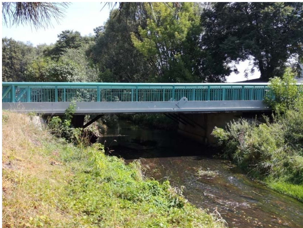
Fot. 1. Widok mostu na rzece Przemszy w km 70+532 od strony wody dolnej.
