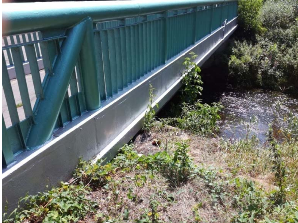
Fot. 2. Widok mostu od strony prawobrzeżnej skarpy
