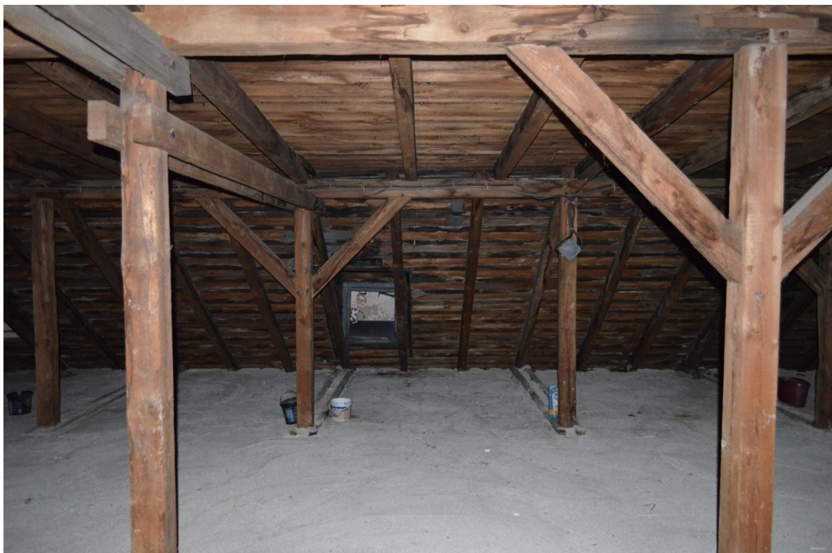
Zdjęcie nr 12 – Konstrukcja więzby dachowej nad salą teatralną
