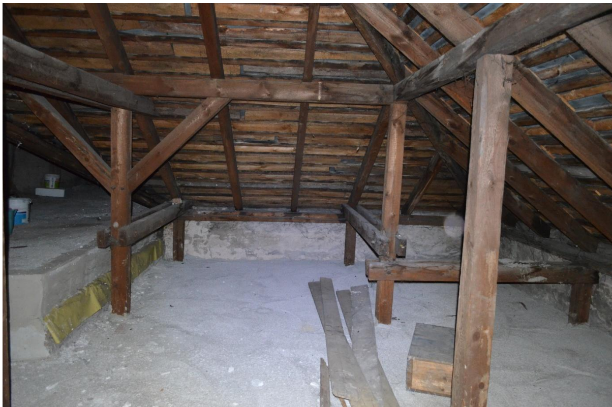
Zdjęcie nr 9 – Konstrukcja więźby dachowej w części dachu bocznego
