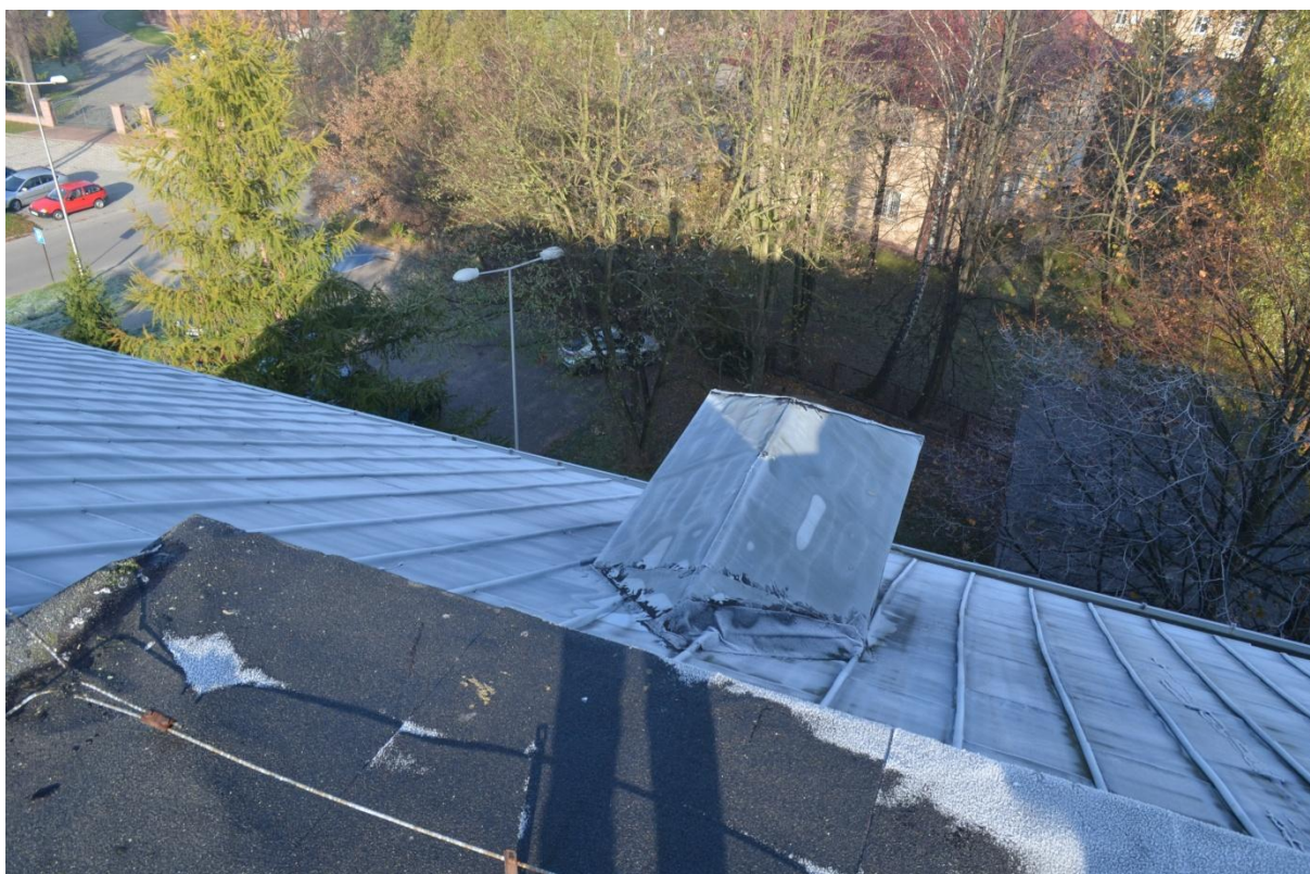
Zdjęcie nr 20 – Pokrycie dachowe lukarny
