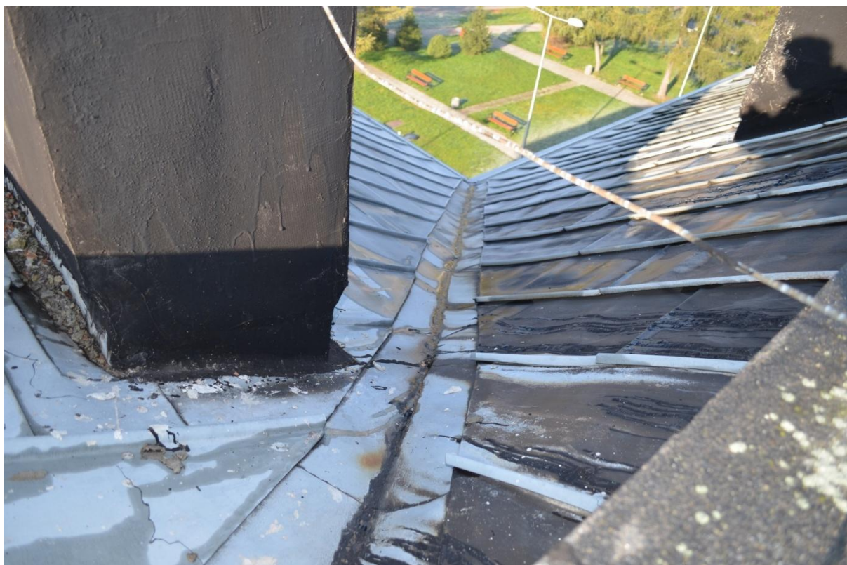
Zdjęcie nr 22 – Krawędź koszowa dachu
