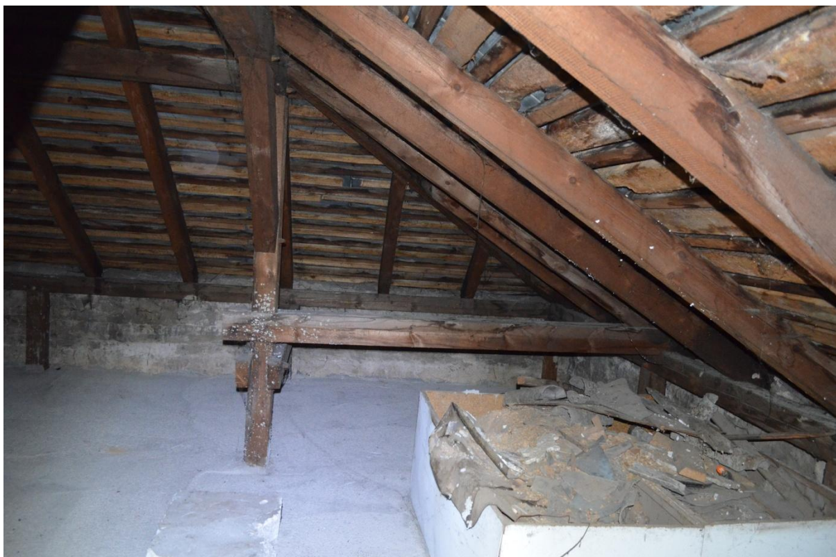
Zdjęcie nr 10 – Konstrukcja więźby dachowej w części dachu bocznego
