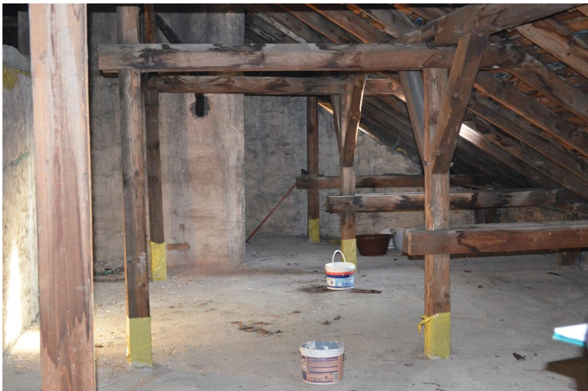
Zdjęcie nr 14 – Widok więźby dachowej w części bocznej
