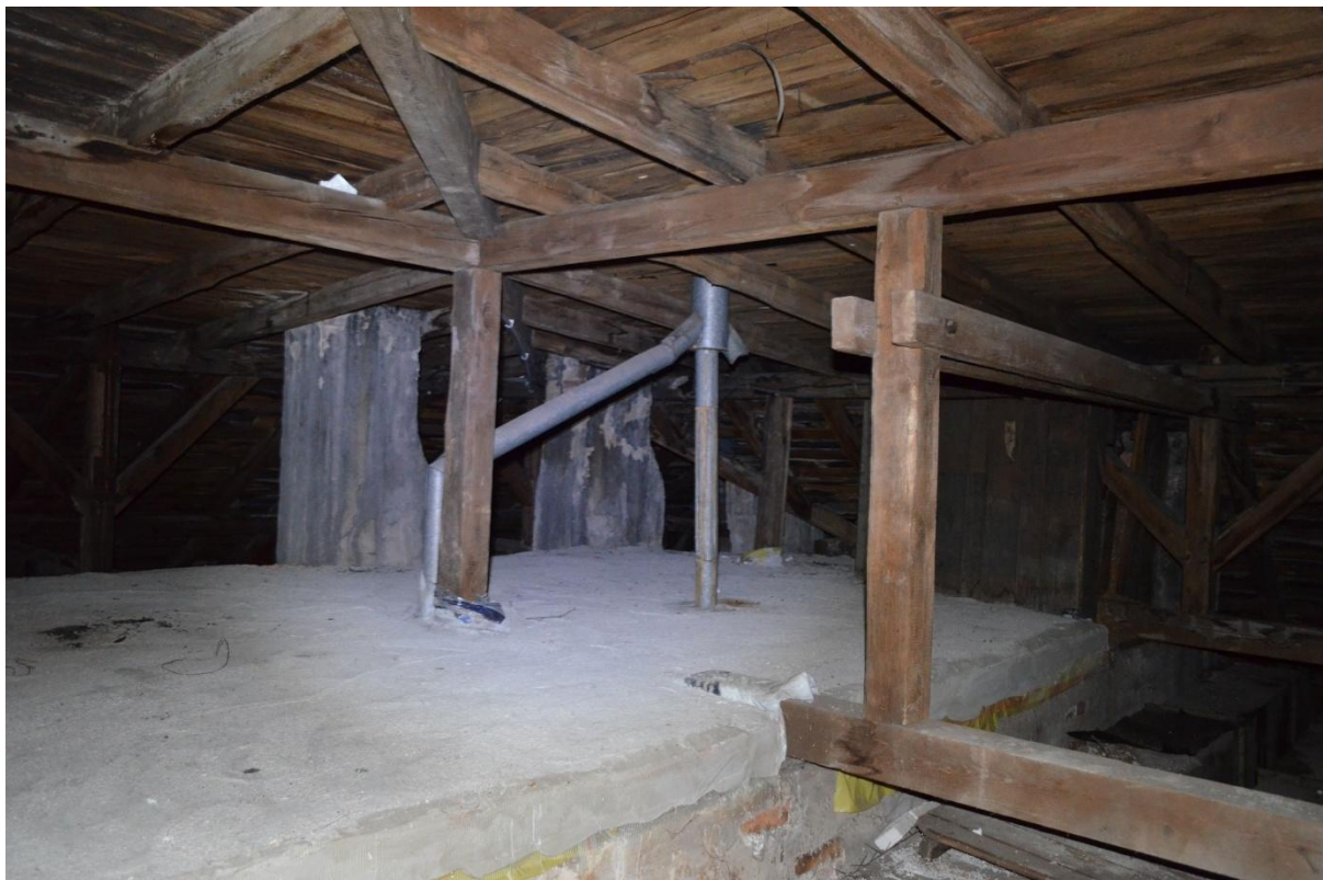
Zdjęcie nr 13 – Więźba dachowa nad korytarzem, wentylacja pomieszczenia z projektorem
