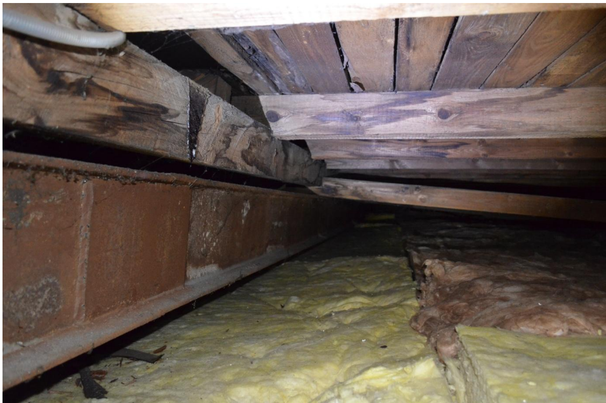
Zdjęcie nr 7 – Dwuteownik I300 jako podparcie dla więźby dachowej nad sceną
