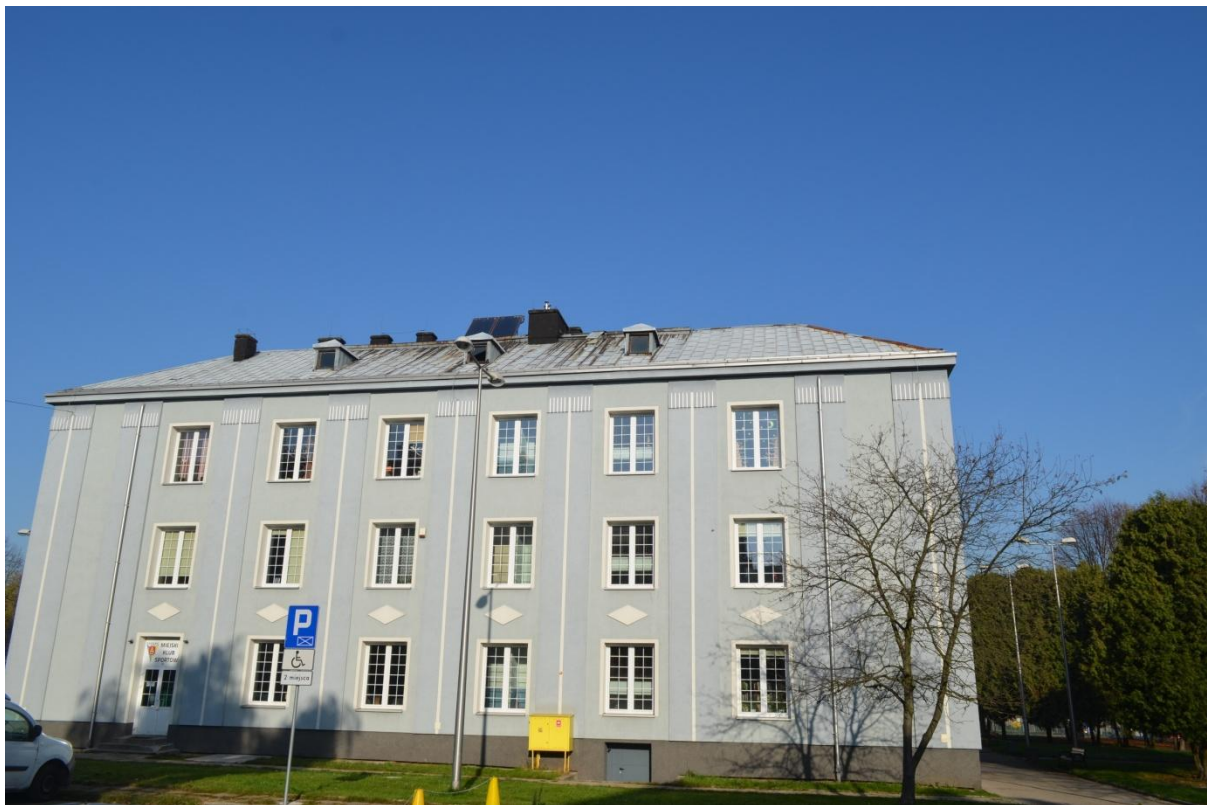
Zdjęcie nr 1 – Elewacja, widoczna połać dachowa z kolektorami słonecznymi i lukarnami
