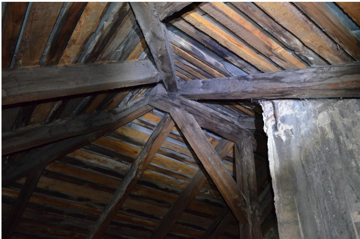
Zdjęcie nr 15 – Węzeł narożny więźby dachowej
