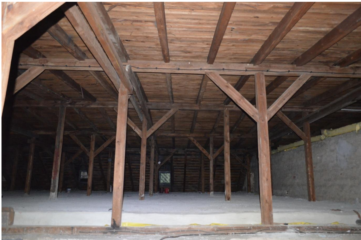
Zdjęcie nr 3 – Poddasze - część nad salą teatralną
